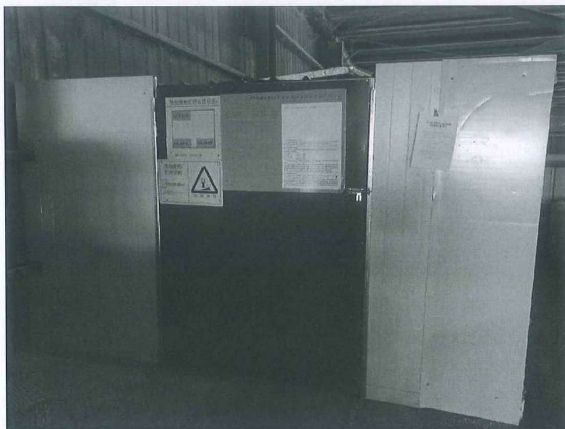
图 4.3 危废贮存仓外部图
