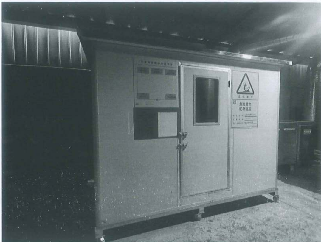
图 4.3 危废贮存仓外部图
