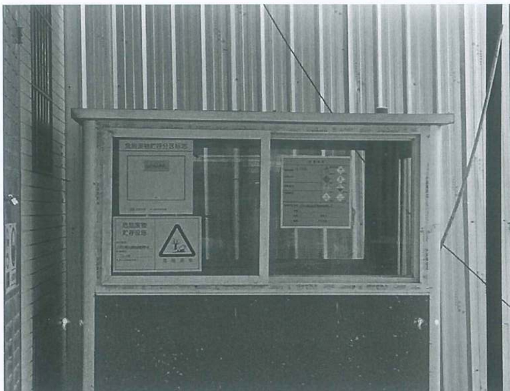
图 4.3 危废贮存仓外部图
