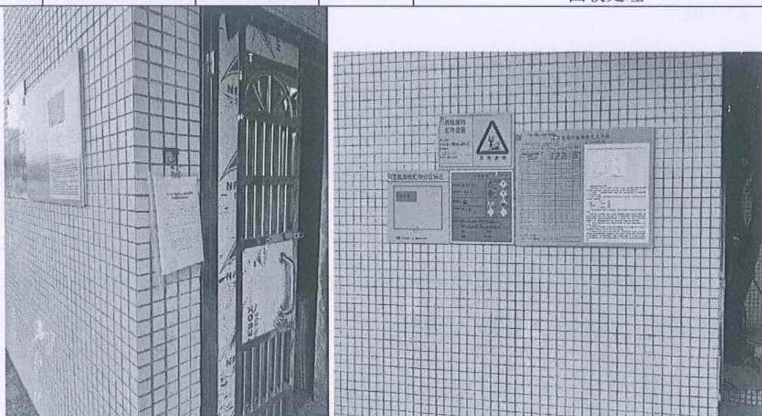
图 4.2 危废间外部图
